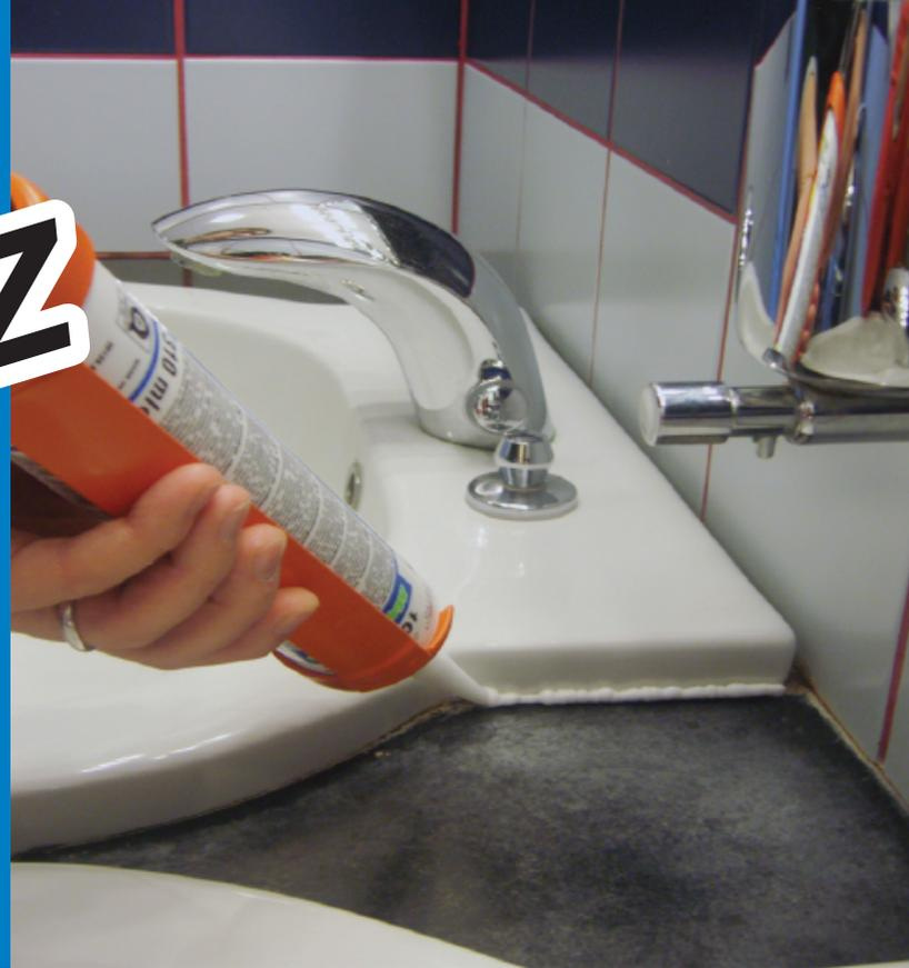
Силиконовый герметик на уксусной основе для санитарно-технического оборудования
