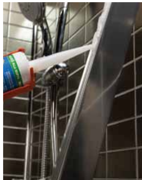
Приклеивание металлического профиля
