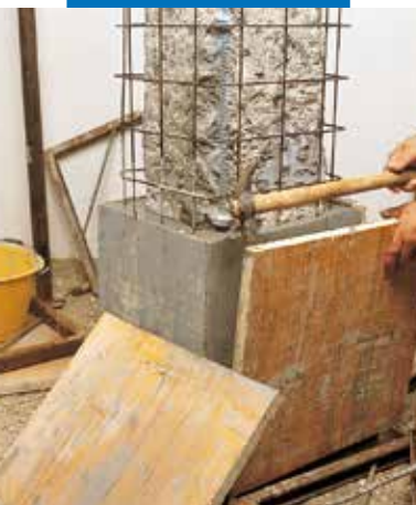
Снятие деревянной опалубки
