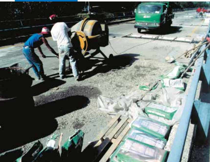
Обустройство дорожных стыков
