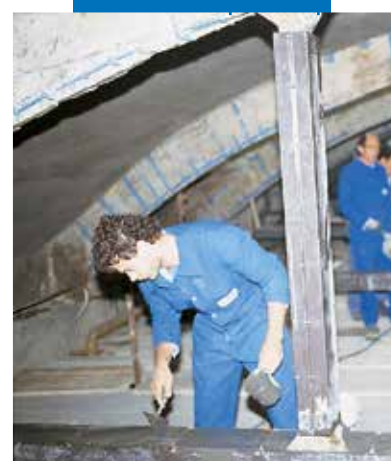
Заливка Mapegrout Hi-Flow в металлическую опалубку
