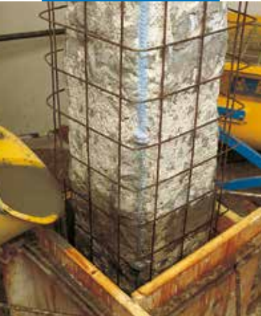
Заливка в опалубку
