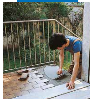
Гидроизоляция и укладка плитки с помощью смеси Kerabond T + Isolastic
