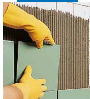
Нанесение поверх старой плитки
