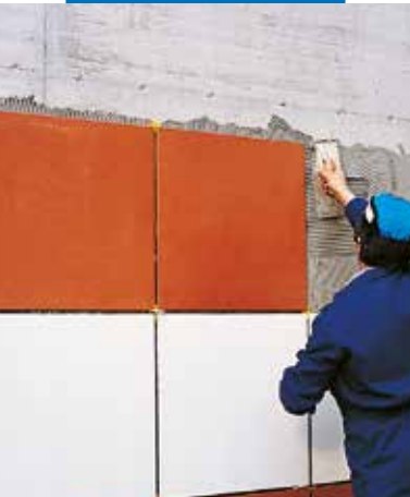
Укладка крупноформатной плитки с помощью Kerabond T + Isolastic
