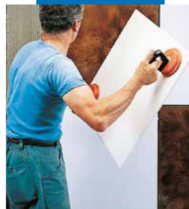
Укладка крупноформатной плитки KERAION на стену
