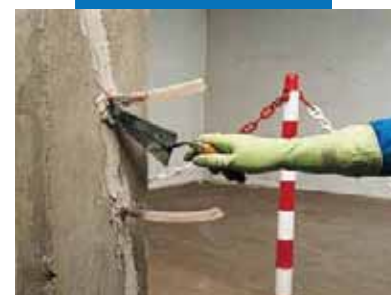
Крепление инъекционных трубочек с помощью Adesilex PG1
