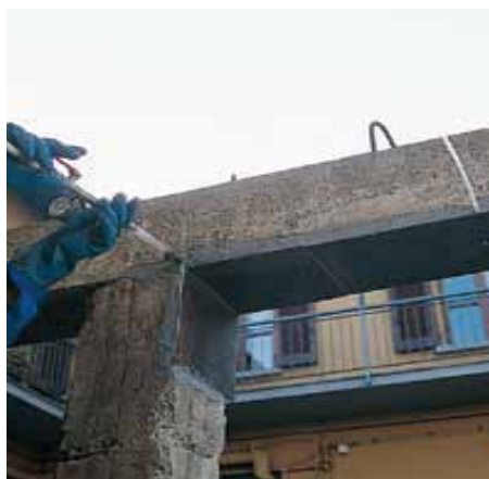
Восстановление балки с помощью Eроjet
