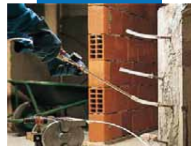
Инъекции Epojet в колонну с трещинами
