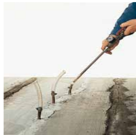
Восстановление горизонтальной конструкции с помощью инъекций Eроjet
