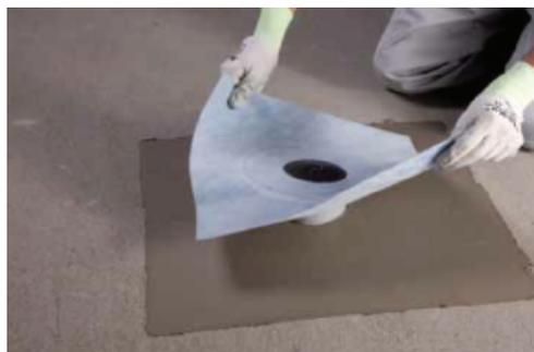
1. Нанесите первый слой специального гидроизоляционного материала MAPEI вокруг водосточной трубы, таким образом, чтобы обработанная площадь была больше, чем мембрана на Drain Vertical и Drain Lateral
