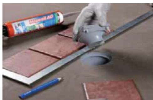
5. Выставьте клапан «антизапах» и точно (4 точки) приклейте удлиняющую насадку к трубе с помощью силиконового герметика Mapesil AC. Очень важно: насадка не приклеивается по контуру, а только по 4 точкам; это позволит направляться воде, которая просачивается между плиткой и гидроизоляционным слоем, в дренажное отверстие, а не накапливаться вокруг трубы
