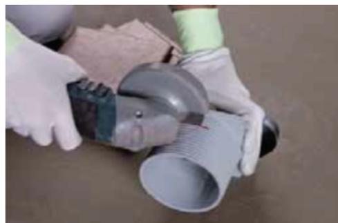
4. Обрежьте удлиняющую насадку по отметке до необходимой высоты с помощью болгарки или пилки
