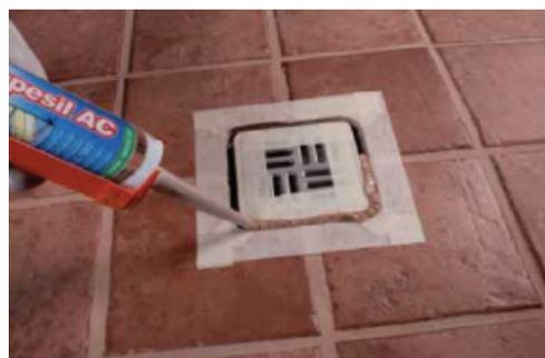
6. После приклеивания напольного покрытия и заполнения швов, заполните герметиком Mapesil AC шов вокруг решетки сливного отверстия на полу
