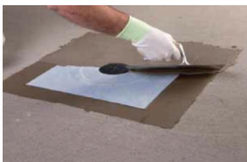
2. Покройте мембрану вторым слоем гидроизоляционного материала MAPEI
