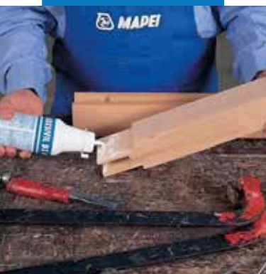
Склеивание деревянных оконных рам для экстерьеров
