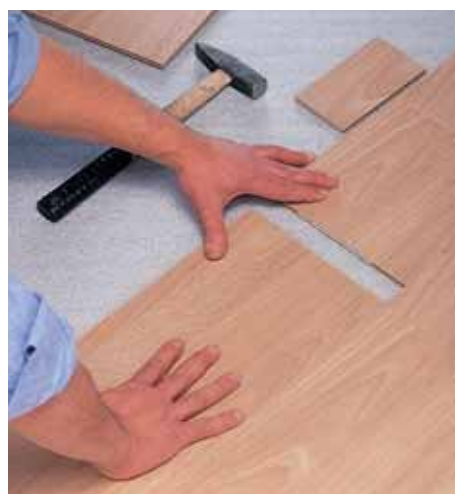
Установка шпунтовых ламинированных напольных покрытий
