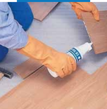
Нанесение Adesivil D3 на шпунтовое ламинированное напольное покрытие
